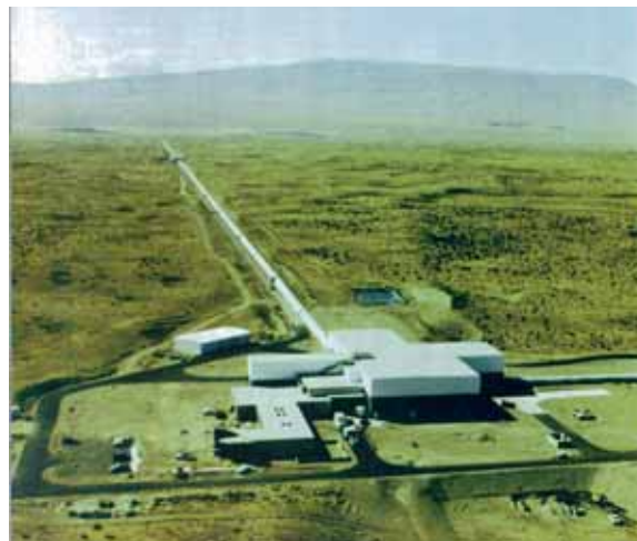
אתר לייגו ליד האנפורד במדינת וושינגטון, ארצות-הברית שתי הזרועות (אחת מוחן נראית במלואה), באורך 4 ק"מ כל אחת, מכילות אינטרפרומטר לייזר לגילוי גלי כבידה באמצעות מדידת שינויים בהפרש האורך בין הזרועות. סדר הגודל של השינויים הנמדדים הוא 10^{-18} מ'
